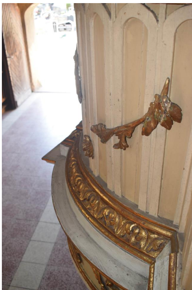
Fot. 24. Fragment kosza ambony z widocznymi pęknięciami drewna, zaprawy i warstw malarskich oraz ubytkami ornamentów.
