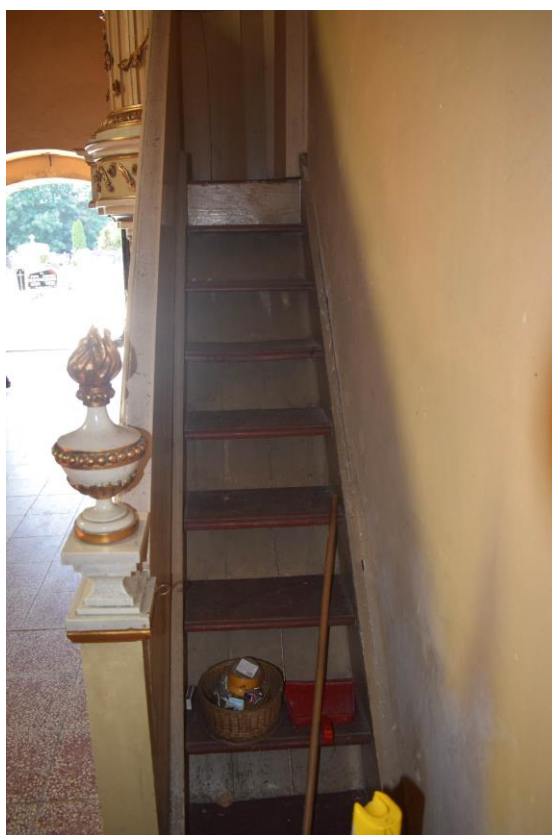
Fot. 22. Bieg schodów.
