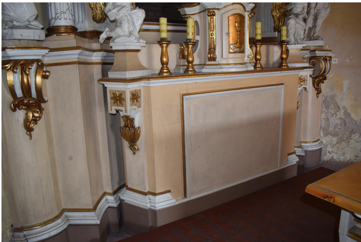
Fot. 5. Dostawka i podstawa ołtarza. Widoczne wtórne zakrycie otworu po mensie płaską płyciną z profilowaną ramką.
