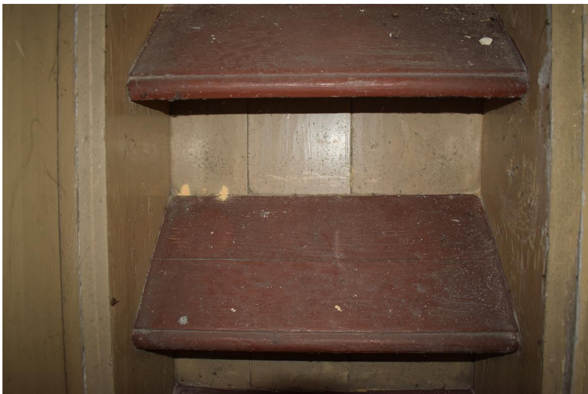
Fot. 23. Stopnice z widocznymi kopczykami mączki drzewnej, świadczącymi o aktywności larw owadów.
