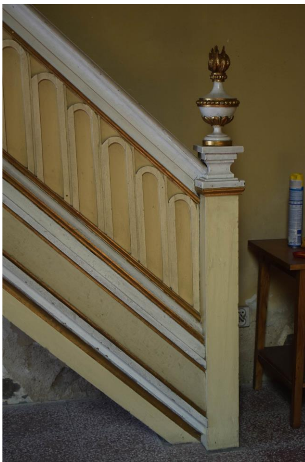
Fot. 21. Dolna część balustrady schodów ze słupkiem zwieńczonym zniczem.
