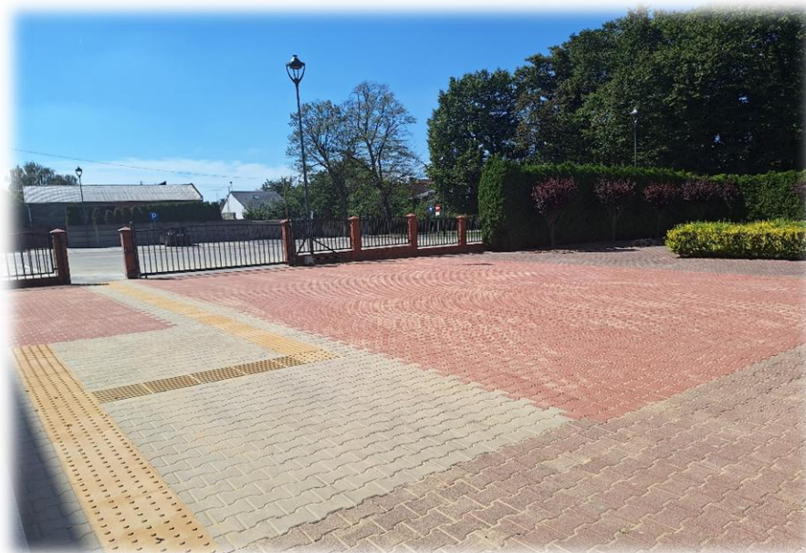
Ryc. 15 Teren przy ul. Ogród Ludowy 2 Krobi (przy ZSOiZ w Krobi) po wykonaniu prac
