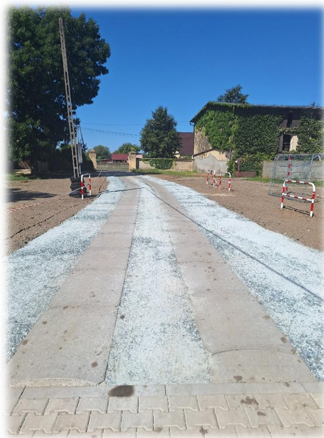
Ryc. 49 Teren utwardzony przy świetlicy wiejskiej w Karcu
