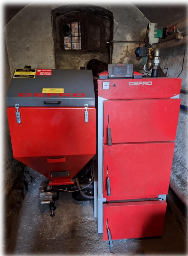
Ryc. 16 Nowy piec zamontowany w budynku gminnym w Chwałkowie 43
