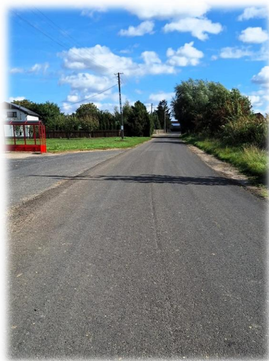
Ryc. 20 Nowa nawierzchnia drogi gminnej Kuczyna – Ziemlin
