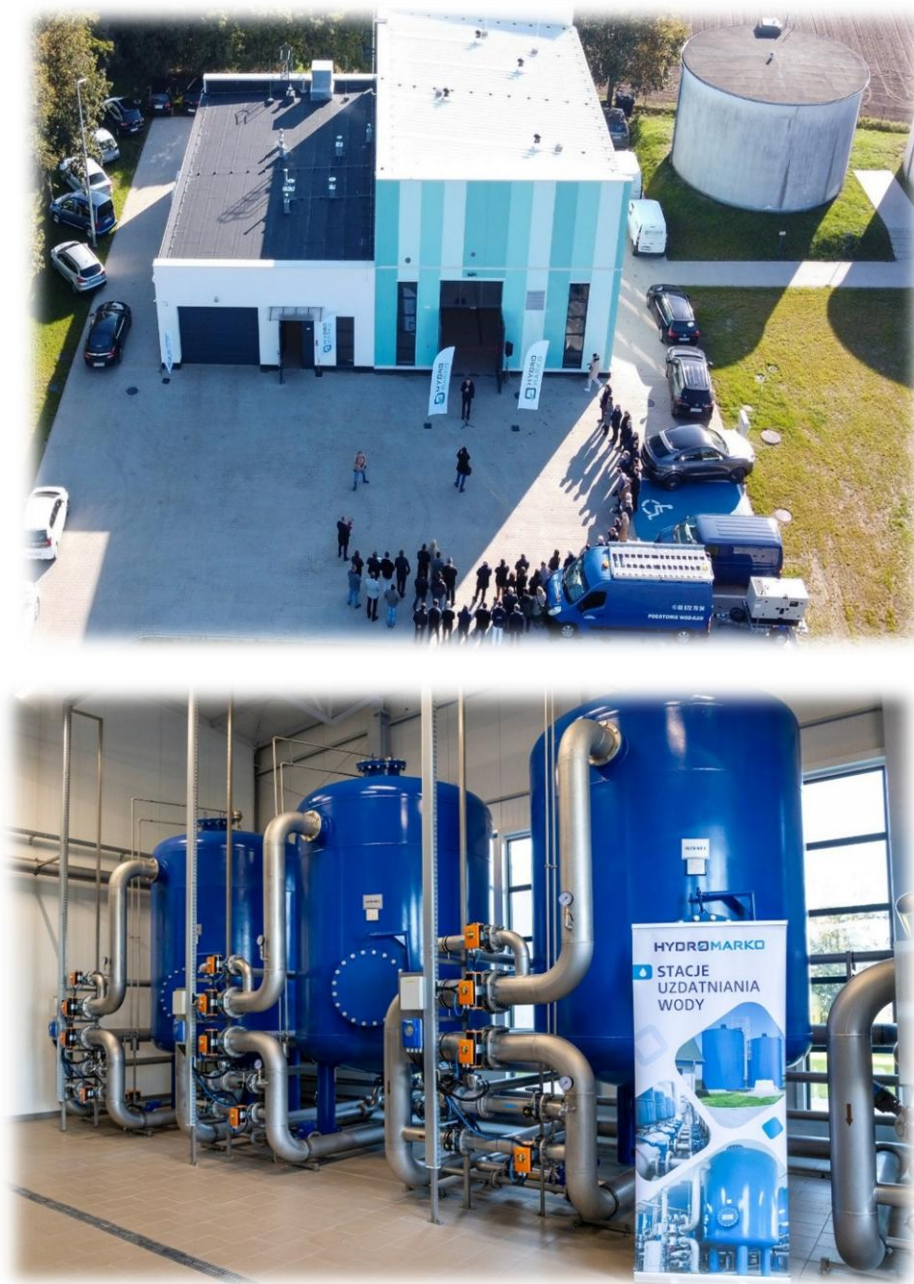
Ryc. 32 Stacji uzdatniania wody w Bukownicy
