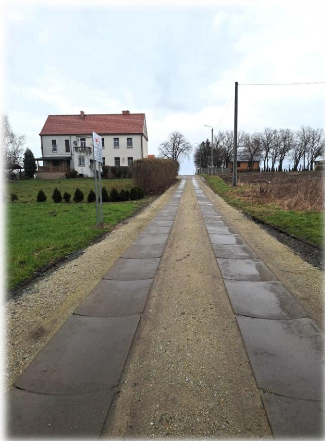
Ryc. 17 Utwardzona droga w miejscowości Domachowo
